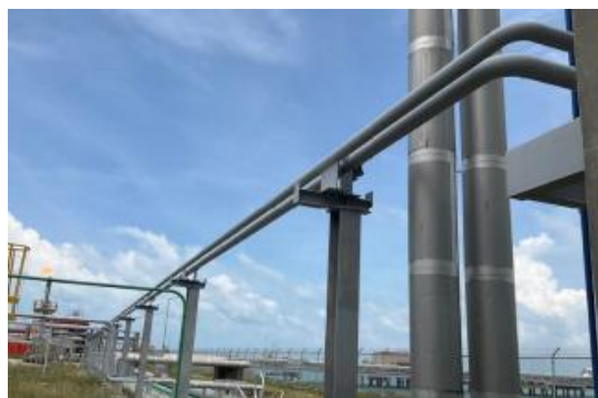
รูปที่ 3-3 ท่อรวบรวมไอน้ำผลิตก๊าซและวัตถุดิบ ที่เกิดจากกิจกรรมการขนถ่ายไปยังหอเผา (Flare)
