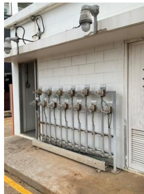
รูปที่ 3-32 Emergency Shut Off Valve ที่ Loading Arm
