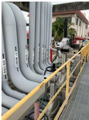
รูปที่ 3-8 ท่อขนส่งน้ำเสีย
