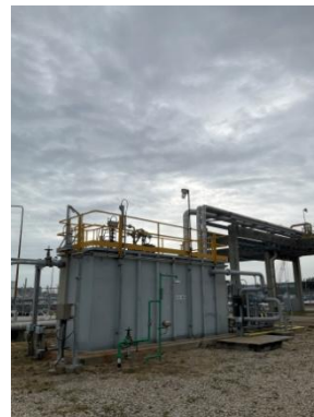
รูปที่ 3-9 ระบบบำบัดน้ำเสียภายในท่าเทียบเรือ (Sanitary Treatment System)
